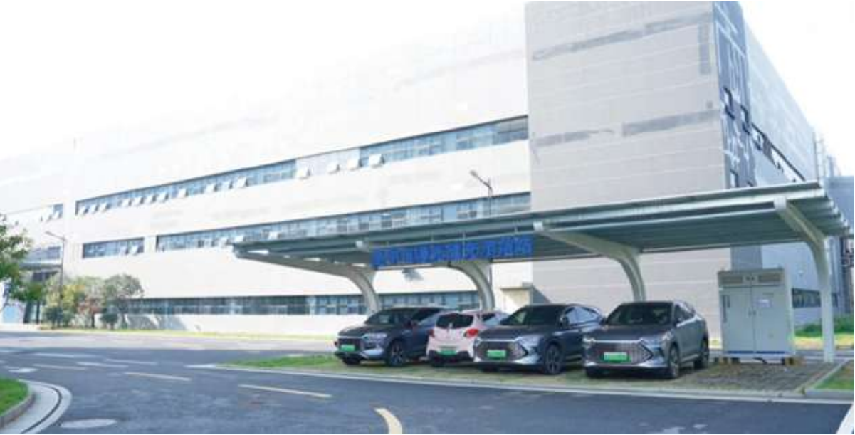
Estación Integrada de Solar-Almacenamiento-Carga Comercial e Industrial de Hunan Changde Proyecto de Almacenamiento de Energía Tiempo del Proyecto: 2023 Ubicación del Proyecto: Hunan,China
