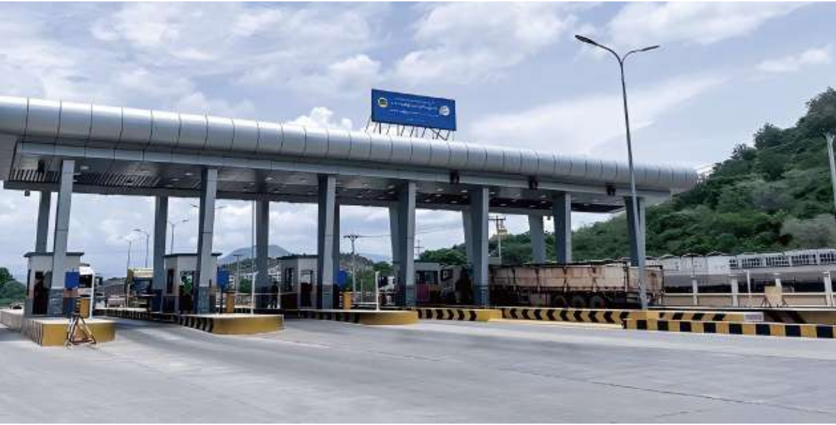
Proyecto de Almacenamiento de Energía Comercial e Industrial de la Estación de Peaje SKG de Mandalay, Myanmar Tiempo del Proyecto: 2023 Ubicación del Proyecto: Myanmar
