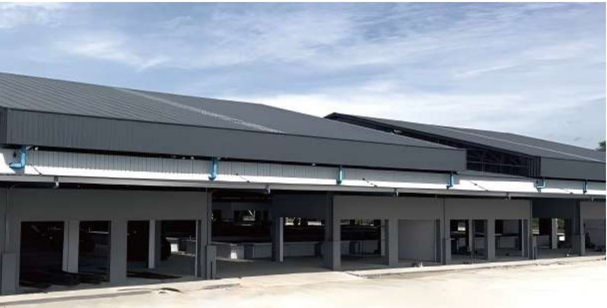
Proyecto de Almacenamiento de Energía Comercial e Industrial del Mercado de Agricultores de Mandalay, Myanmar Tiempo del Proyecto: 2023 Ubicación del Proyecto: Myanmar
