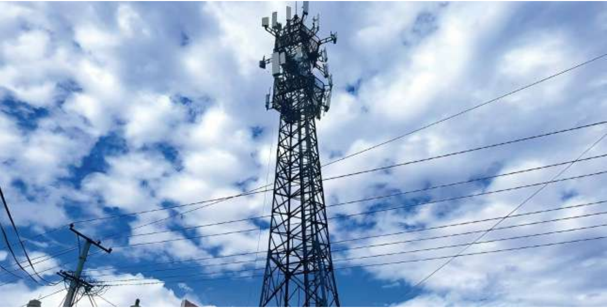
Proyecto de batería de sodio inteligente de China Mobile Heilongjiang Tiempo del proyecto: 2024 Ubicación del proyecto: Heihe,Heilongjiang, China
